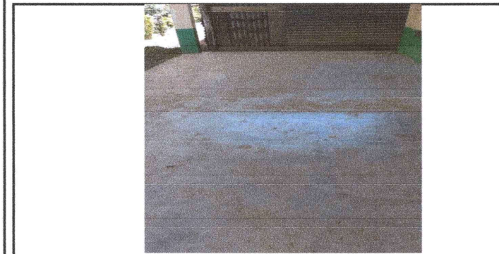
FOTO 4: Colocacion de piso ceramico
