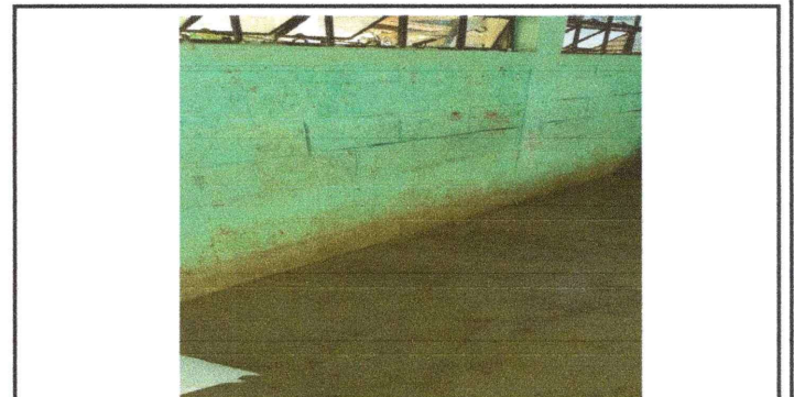
FOTO 5: Cambio de pintura
