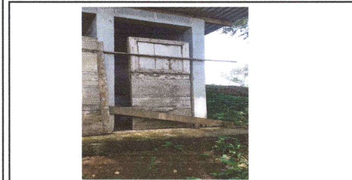
FOTO 3: Sustitucion de puerta de baño
