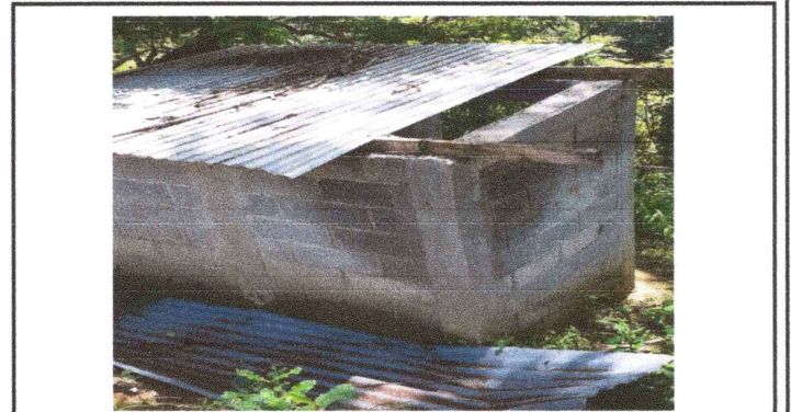
FOTO 2. Cambio de techo de baño
